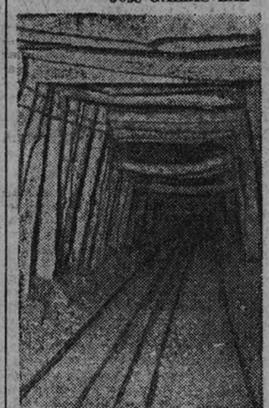
Intensa fortificación de madera en galería de transportes, en la que se aprecian fuertes presiones del terreno y distintos desmoronamientos del techo a causa de la frecuente renovación que hay que hacer de dichas fortificaciones.
