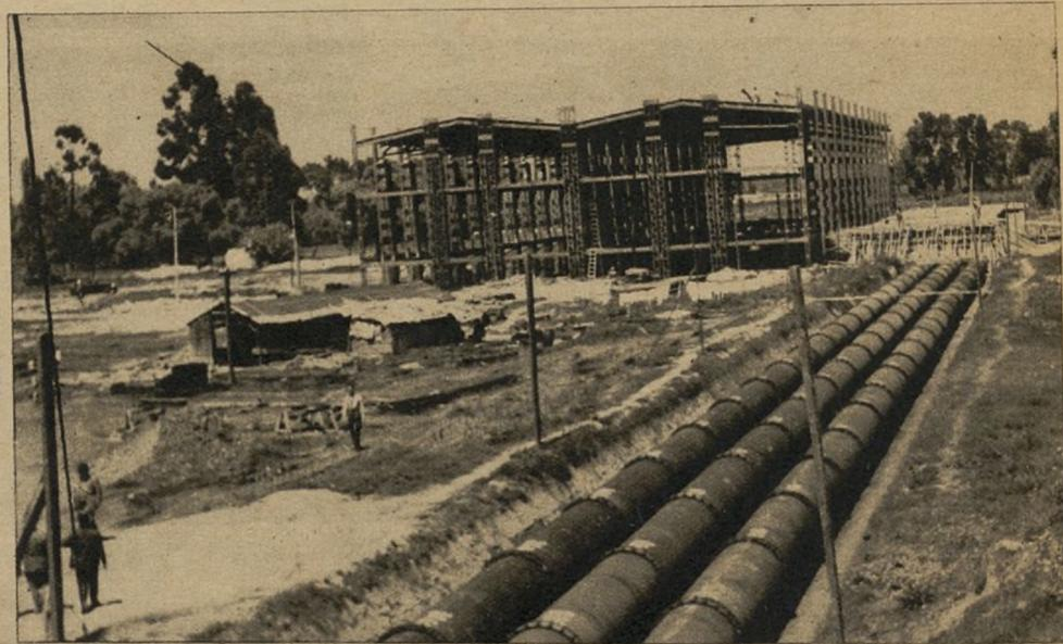
Tubo de tubería de acero que sustituye al antiguo acueducto en su entrada a la planta de distribución de Xotepingo, D. F.
