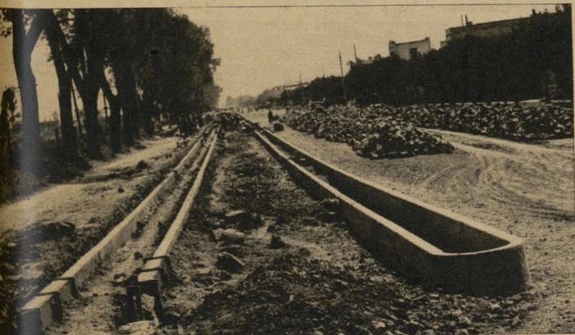
Detalle de las obras de pavimentación y ampliación de la calzada de Tlalpa terminando el embanquetado de concreto, el espacio de peatones.
