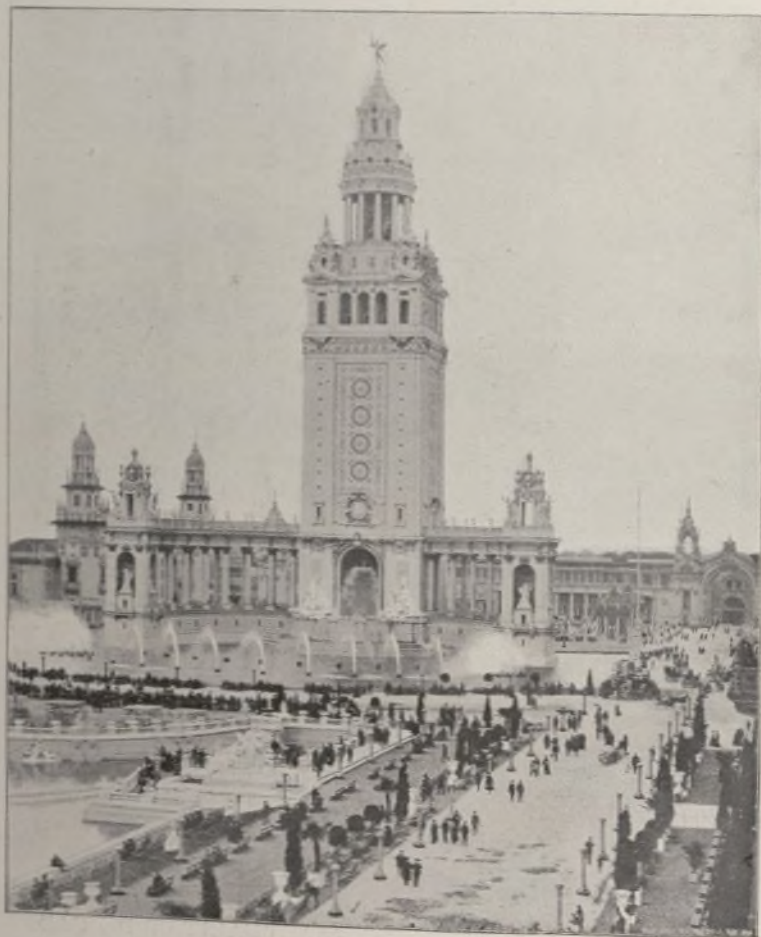
«LA TORRE ELÉCTRICA»
