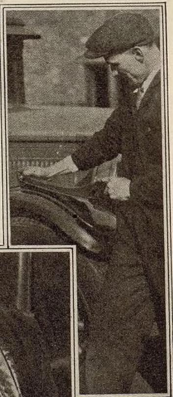
área caliente. De esta manera el metal se lleva hacia el centro. Cuando se trabaja alrededor de un borde, es necesario primero golpear las abolladuras por la parte inferior. Se coloca después un sostén del radio que sea correcto contra el lugar en donde se va a trabajar, empleando un martillo de acero para enderezar el trabajo. Una serie de golpes suaves y esparcidos dan resultados muchos mejores que pocos golpes fuertes.
