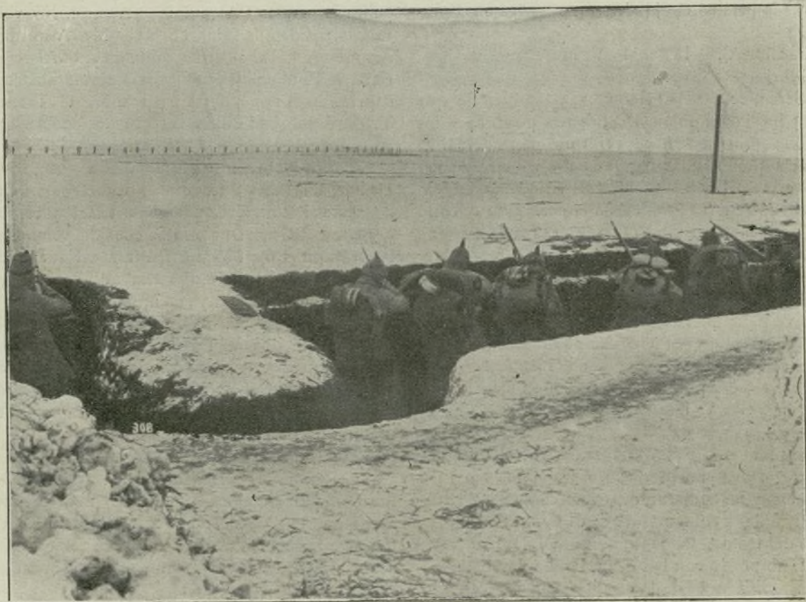
Trincheras alemanas en los lagos mazurianos; delante se ven las alambradas
