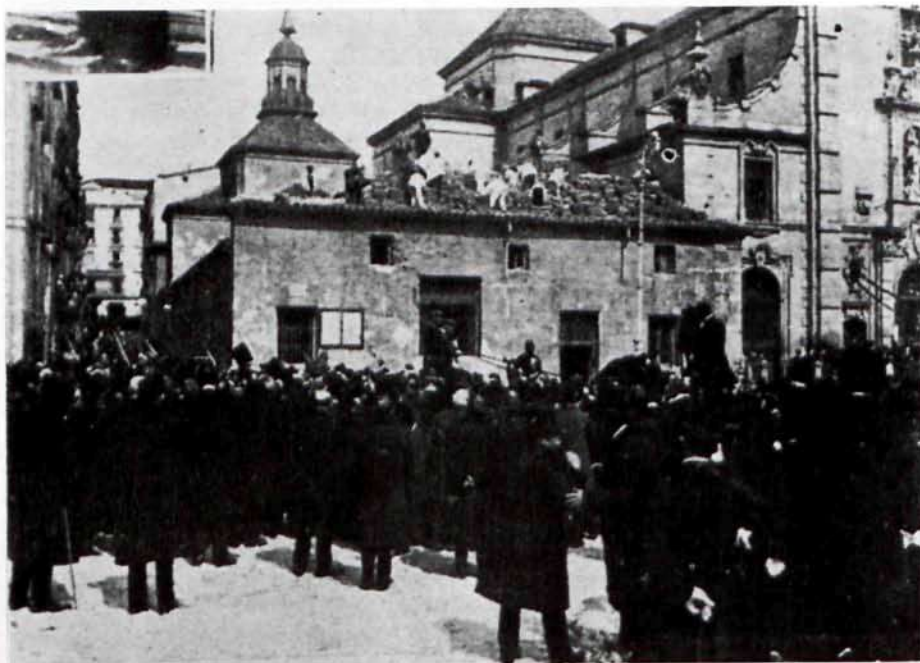
Con un golpe de piqueta, dado por el Rey Alfonso XIII, comenzaron los derribos necesarios para la construcción de la Gran Vía.
