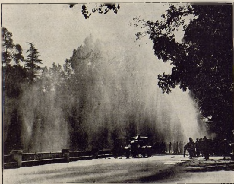
Ensayos de utilización del tanque en proyección horizontal.
