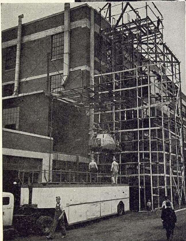
**MAS EFICAZ . . .** Ahorro de tiempo y mayor eficacia en el manejo de carrocerías resultan de la instalación de un nuevo levantador en la fábrica del Cadillac y LaSalle. El antiguo método de levantar las carrocerías se muestra detrás del nuevo levantador. Gracias al nuevo sistema, la compañía podrá manejar 50 carrocerías por hora, contra el máximo de 18 por el antiguo método.
