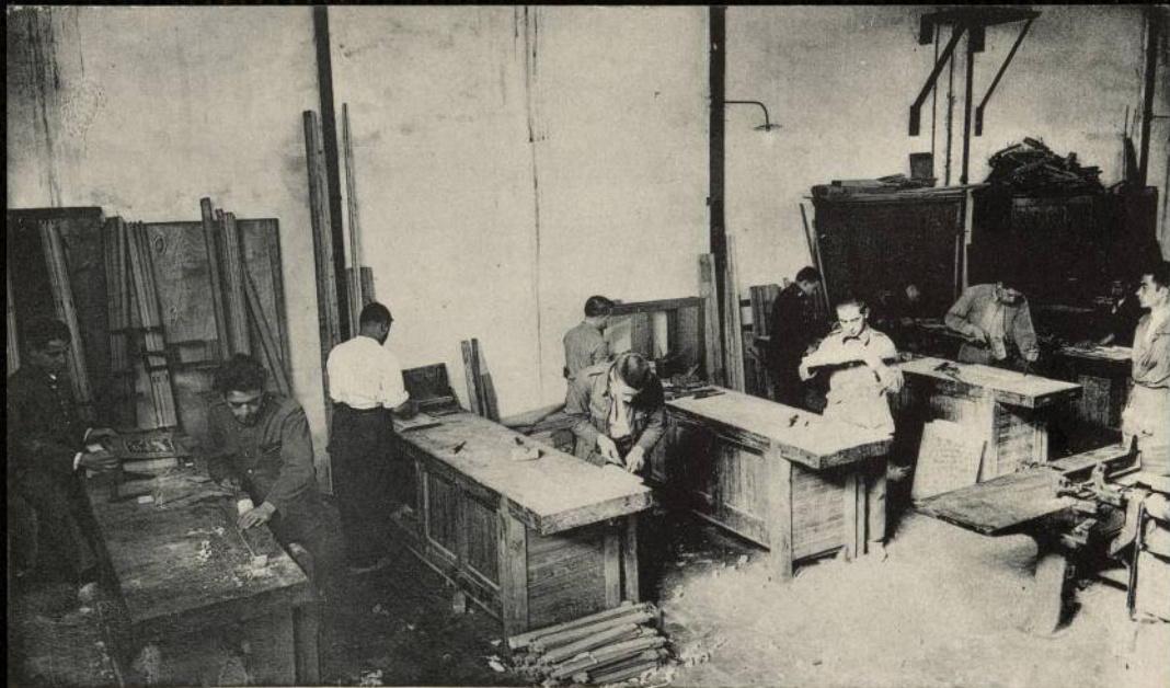
ESCUELA DE MECÁNICOS DE AVIACIÓN. MADRID. (CUATRO VIENTOS) TALLER DE CARPINTERÍA.
