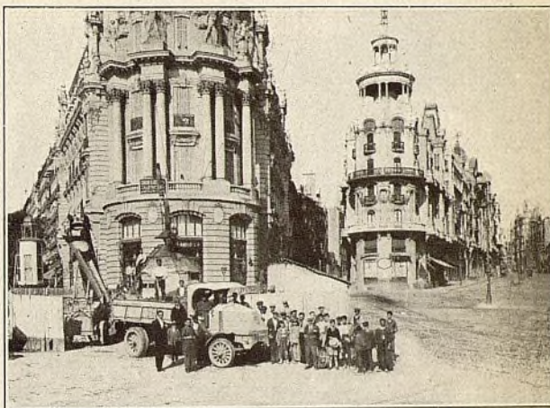
Pozo de trabajo frente a la Gran Vía.
