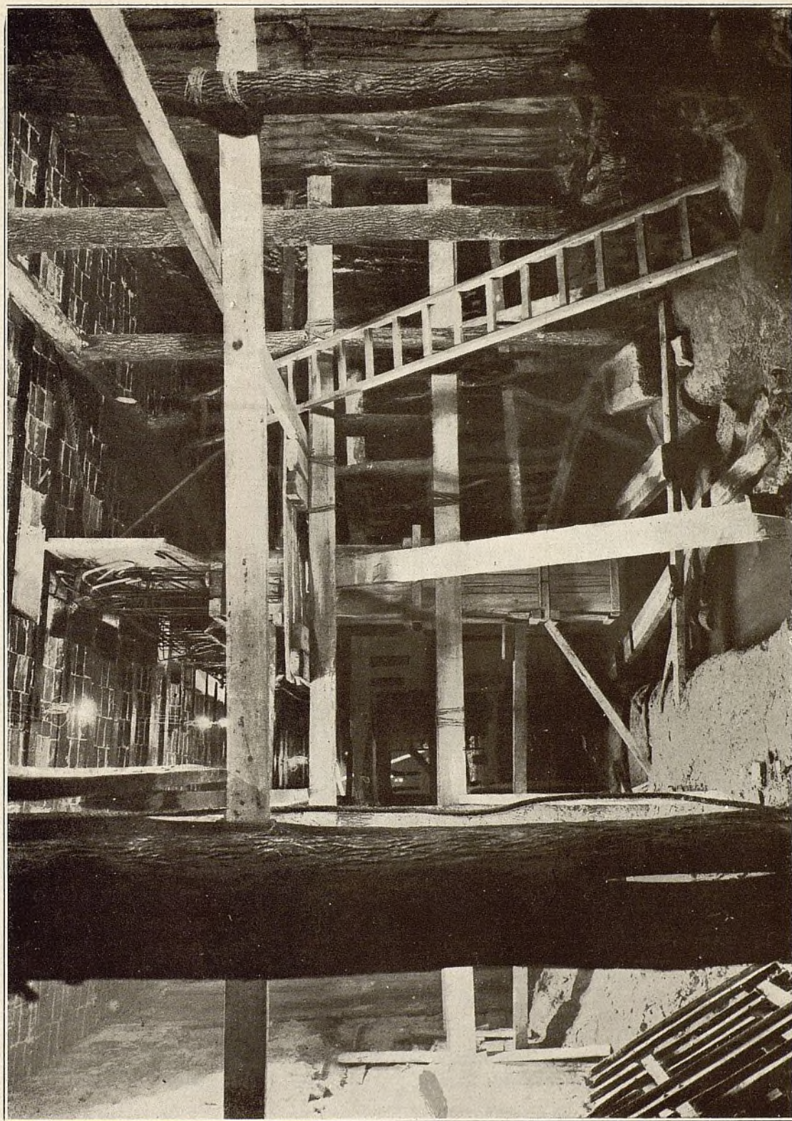
Fig. 16.—Obras en el paso de la Cibele. En el centro aparece el encofrado de la pilastra que en su parte superior lleva el armado del larguero central. (Fase 5. a de la Lámina 6.)
