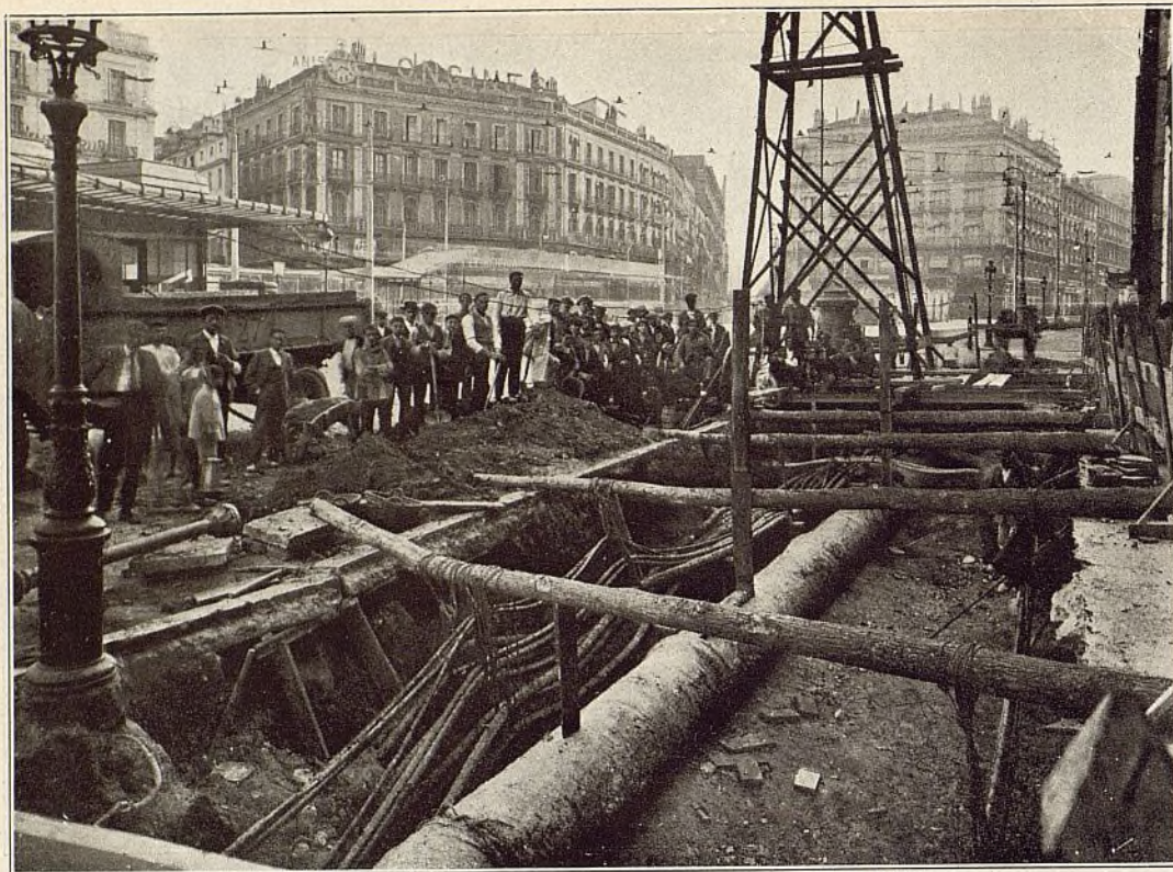
Fig. 3.—Trabajos de desviación de tuberías en la Puerta del Sol.
