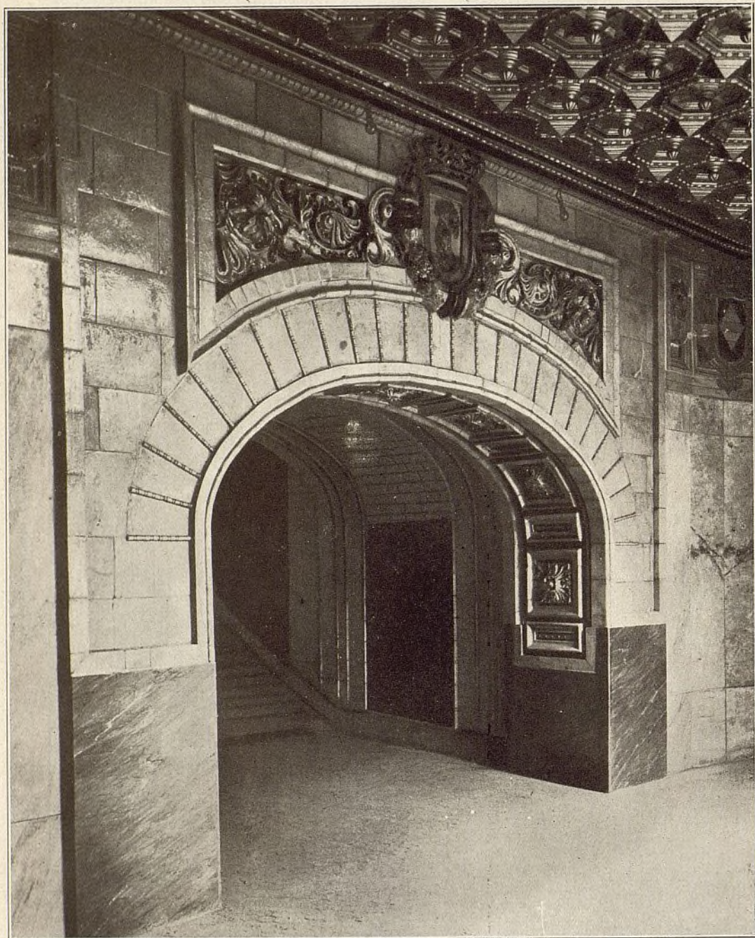
Fig. 9.—Vestíbulo de la Puerta del Sol.—Detalle de uno de sus arcos de ingreso.
