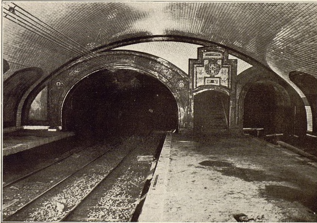
Fig. 10.—Estación del Retiro. Es de triple vía; las dos de la izquierda para el servicio Ventas-Sol y la tercera servirá la futura línea del Barrio de Salamanca.
