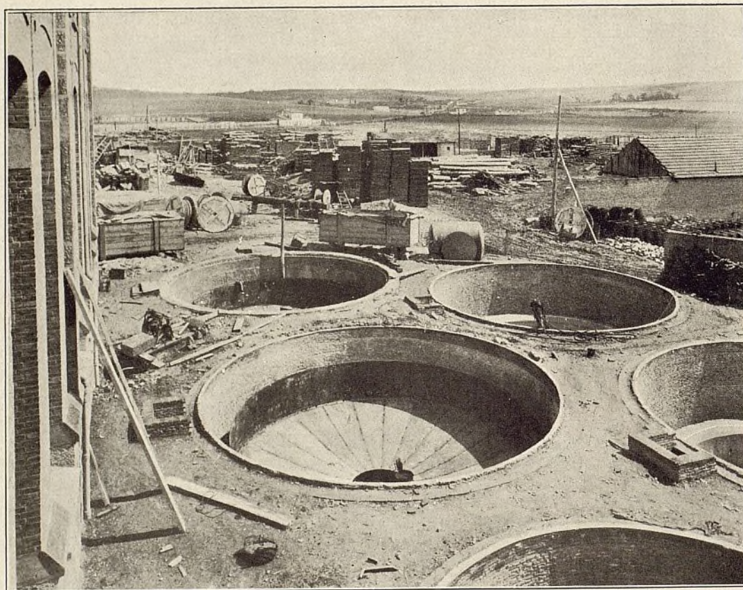
Fig. 22.—Depósitos subterráneos de combustible de la Central del Pacífico.
