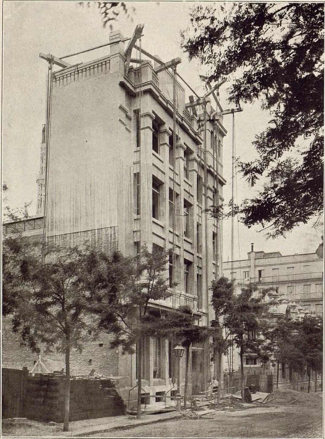
Fig. 24.—Subestación de Salamanca.
