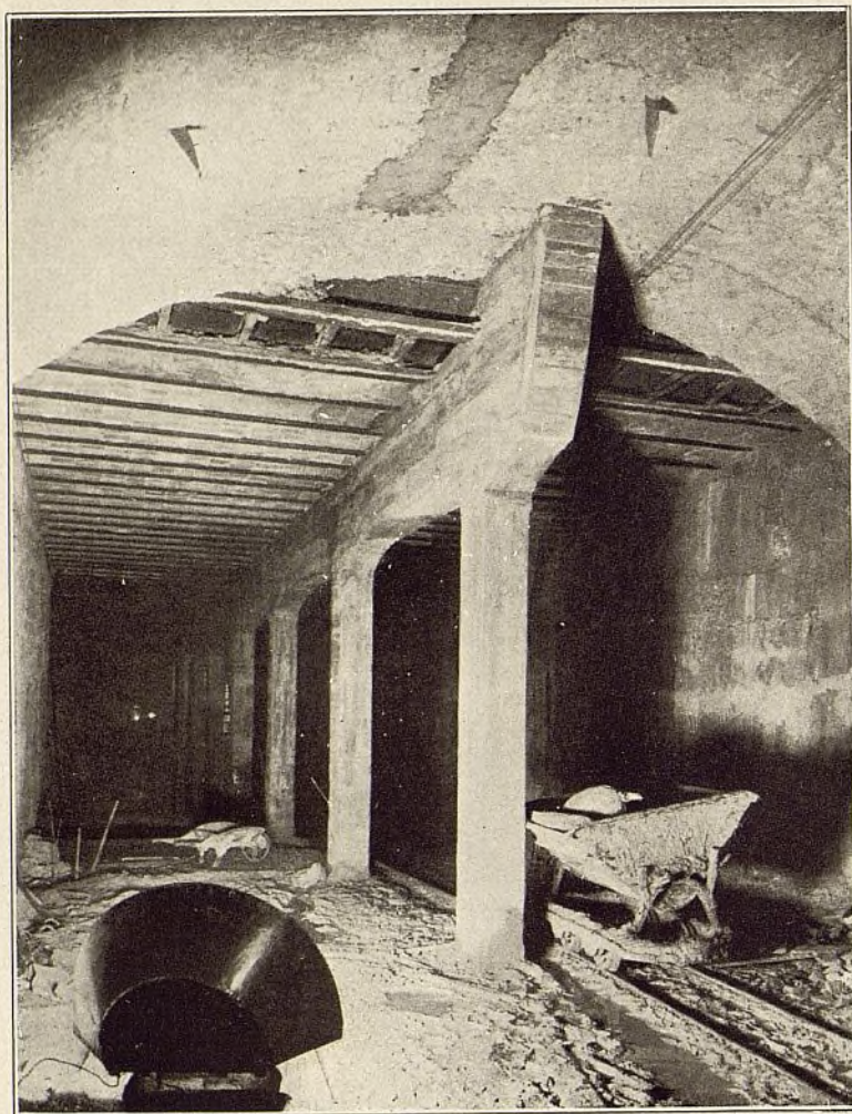
Fig. 17.—Sección del túnel terminada en la Cibeles.
