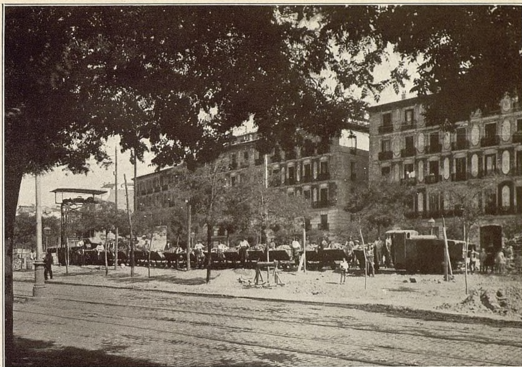
Fig. 2.—Tren de vagonetas remolcado por locomotora de gasolina.
